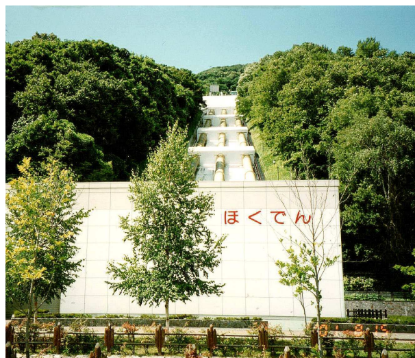
北海道電力・藻岩発電所
